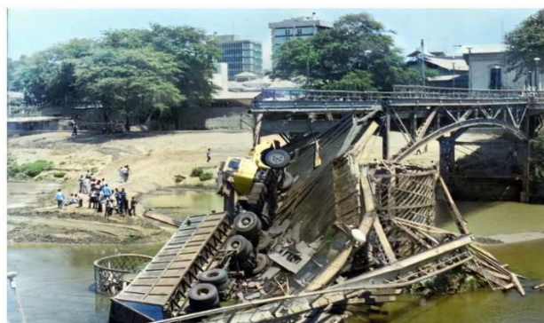
Puente Viejo de Piura colapsado por el paso de Camión de Carga – 26 de Agosto de 1,981.
